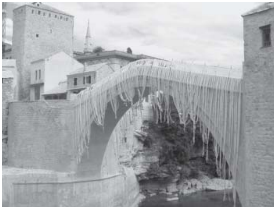
Im Juli 2004 wurde die im Krieg zerstörte und nun wieder aufgebaute Alte Brücke in Mostar feierlich eingeweiht. Heute soll sie das friedliche Zusammenleben der Volksgruppen in der Stadt an der Neretva symbolisieren. Bild: Mura Palasek
