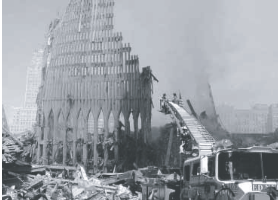
Bergungstrupps haben ein sieben Stockwerke hohes Reststück des World Trade Center für ein künftiges Mahnmal gegen den Terrorismus gesichert. Genaue Pläne für dessen Gestaltung, mit dem zugleich der etwa 6000 Opfer des Anschlags auf das WTC gedacht werden soll, gibt es bisher noch nicht. Das Fassadenteil soll nach den Vorstellungen der New Yorker Stadtverwaltung jedoch deutlich sichtbar aufgestellt werden. Bild: dpa
