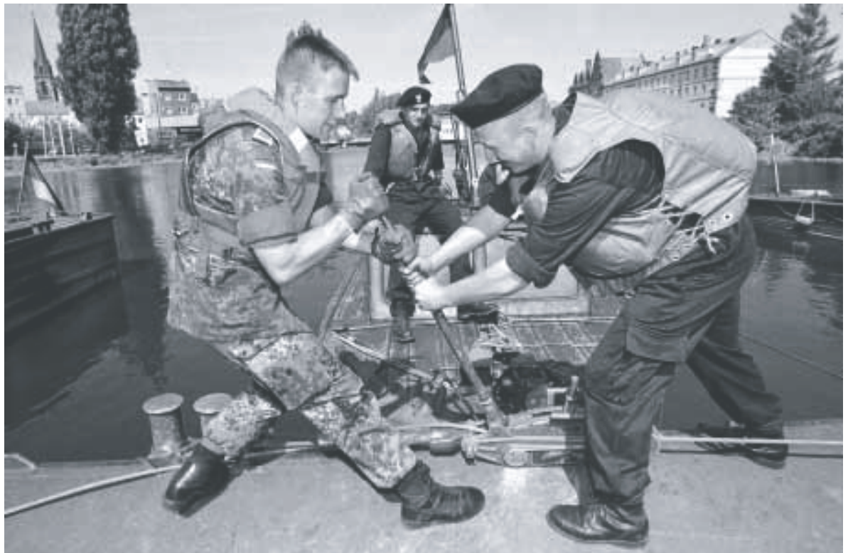
Ein Bundeswehrosoldat zurt gemeinsam mit einem polnischen Gefreiten die letzten Teile einer Pontonbrücke über die Neiße an der deutsch-polnischen Grenze fest; im Hintergrund links die brandenburgische Stadt Guben, rechts der polnische Teil Gubin. Angehörige der Bundeswehr und der polnischen Armee proben hier im August 1998 einen Brückenschlag. Der Katastrophenschutz beider Länder arbeitet gleichzeitig in einer „Rahmenübung Katastrophenschutz“, die ein Zusammenwirken der Rettungskräfte beider Länder erprobt. Bild: dpa
