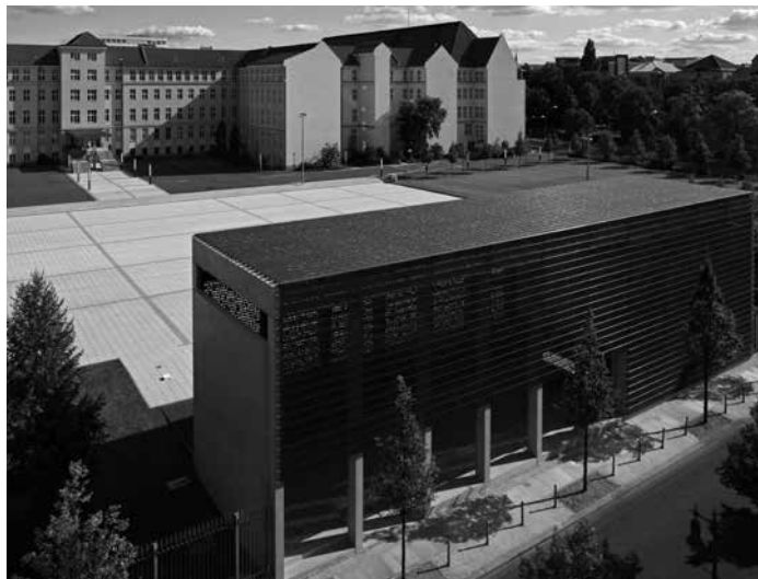
Nur eine repräsentative „Kranzabwurfstelle“? Das Ehrenmal im Bendlerblock liegt auf dem Gelände des Verteidigungsministeriums.
